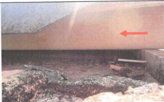
Madeira sem danos
