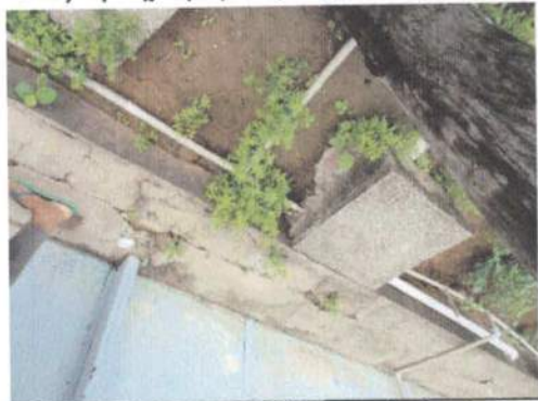
Tubulação de água sem embutir
