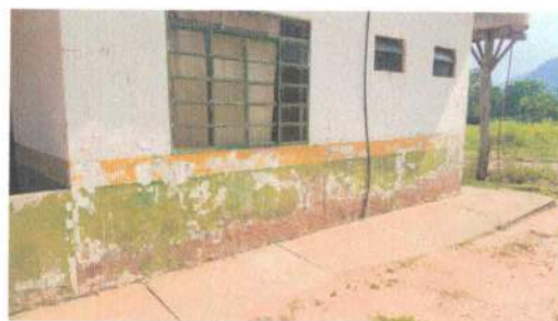
Vista lateral da escola
