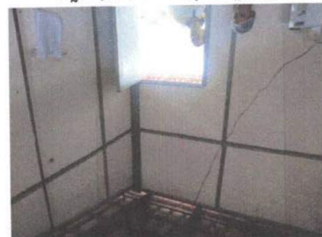
Flaço solta sem proteção
