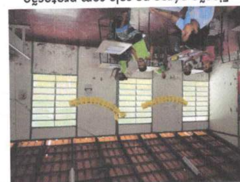
Flaço aérea na sala sem proteção
