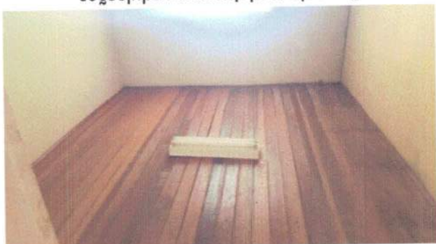
Fôrro de madeira com ondulações
