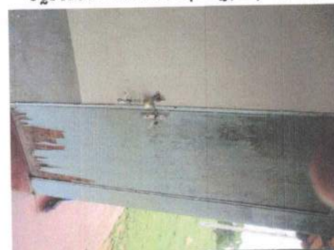
Porta danificada sem recuperação
