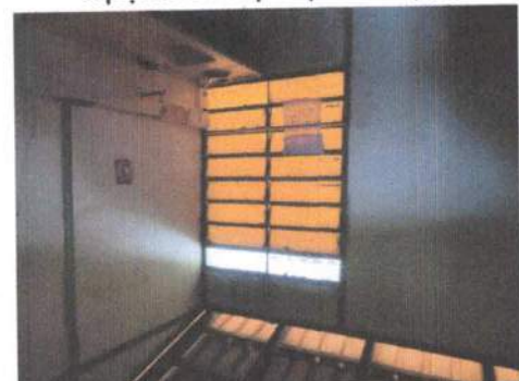
Flaço aérea na sala sem proteção
