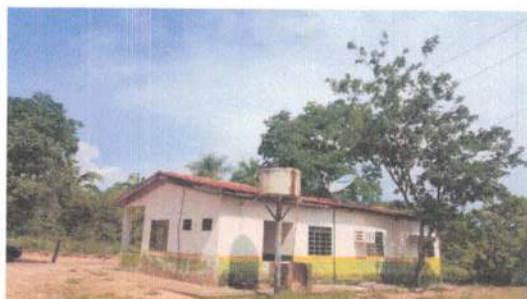
Vista do fundo da escola
