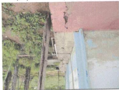
Tubulação de água sem embutir
