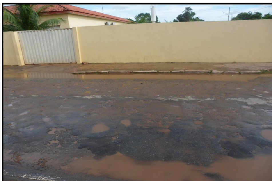
Foto - 13 e 14: Nestas fotos mostram as intervenções de tapa buracos ao longo dos anos, sem critérios técnicos; Mais um caso de mau funcionamento do dispositivo de drenagem superficial.
