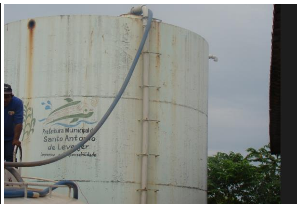
Figura 54. Reservatório bairro da Laje - 50 m 3
