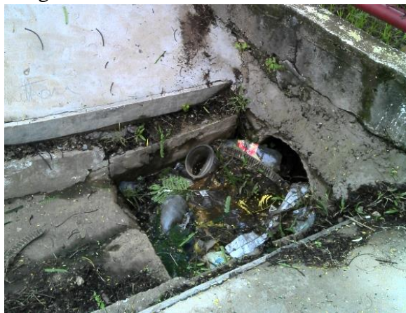
Figura 80. Boca de lobo obstruída Rua C
