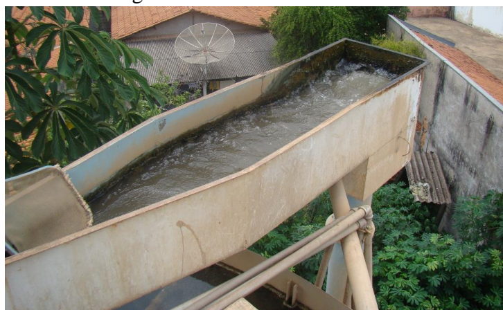
Figura 39. Calha Parshall
