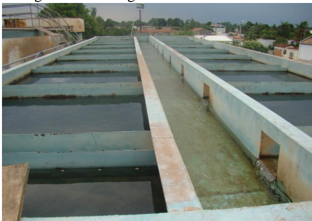
Figura 41. Vista geral do decantador
