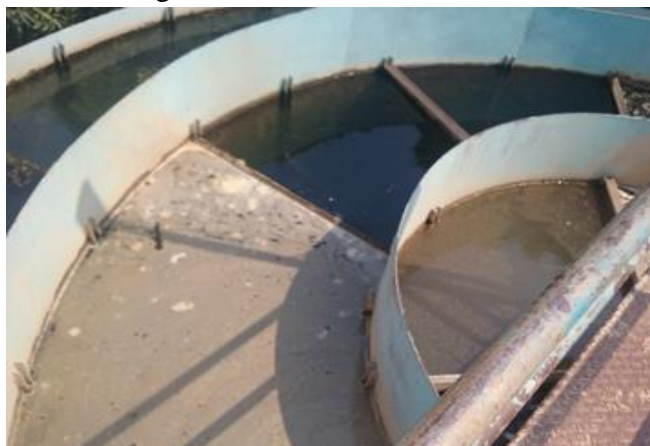
Figura 40. Floculador cilíndrico
