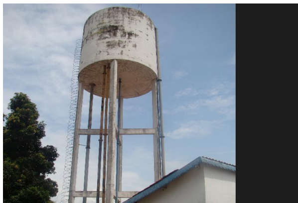
Figura 53. Reservatório concreto elevado - 250 m 3
