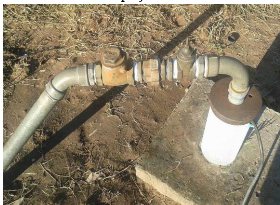
Figura 33. Laje de proteção e cavalete do poço 3
