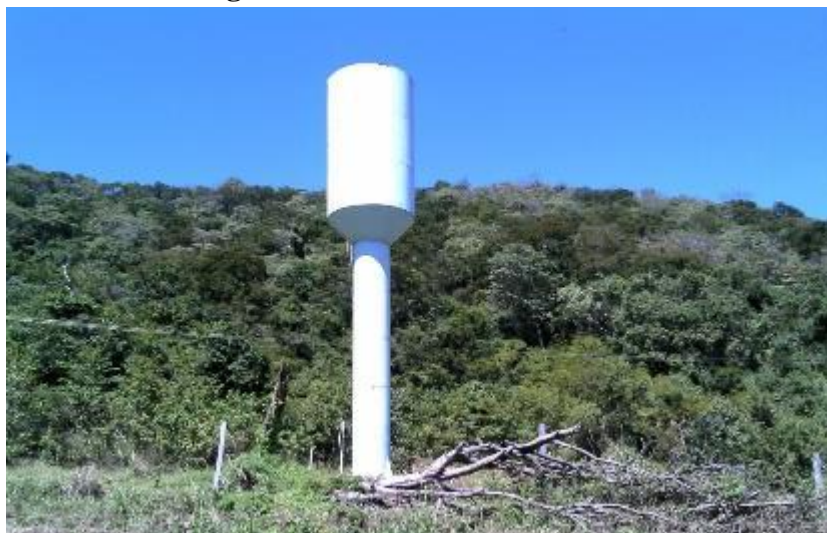
Figura 127. Reservatório metálico
