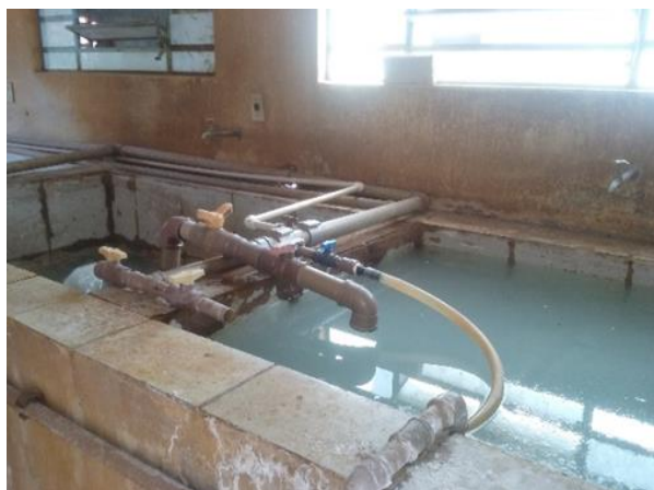
Figura 49. Reservatório de sulfato de alumínio
