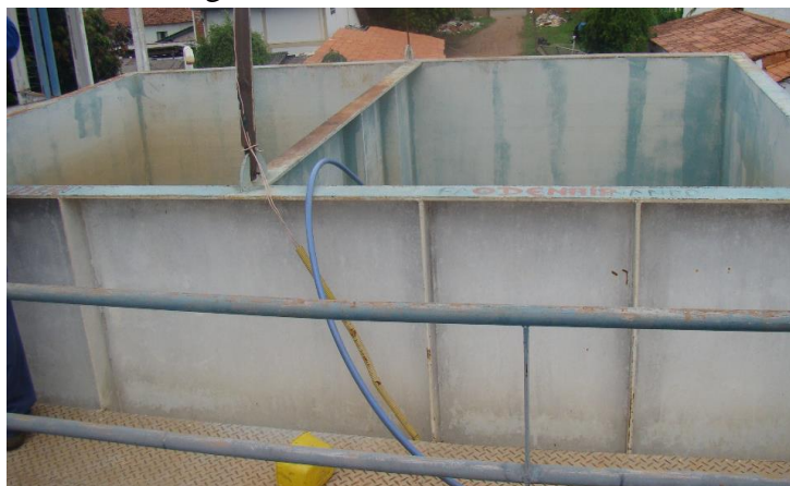
Figura 42. Filtro metálico
