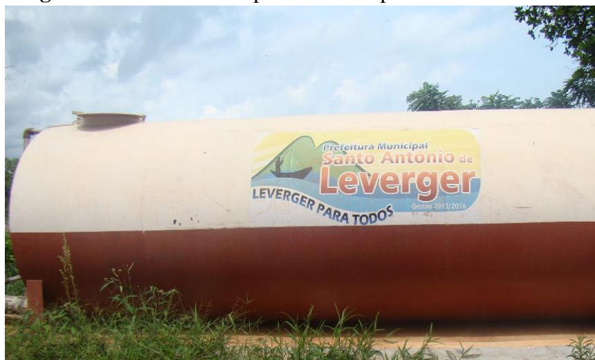
Figura 57. Reservatório apoiado N.S. Aparecida - 25 m 3
