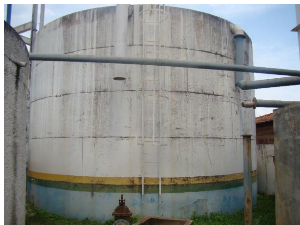
Figura 52. Reservatório metálico apoiado - 350 m³
