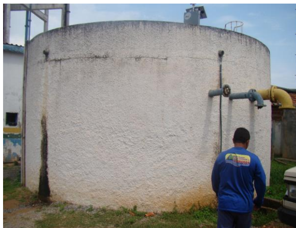
Figura 51. Reservatório concreto apoiado - 150 m³
