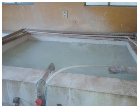
Figura 50. Reservatório de sulfato de alumínio
