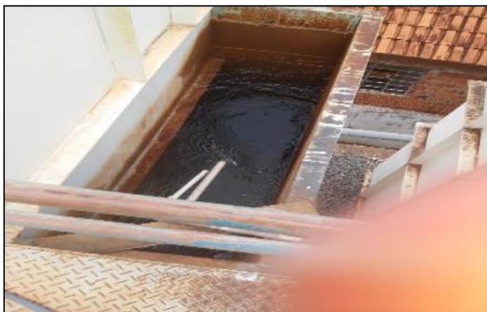
Figura 43. Decantador de alta taxa, coberto, da ETA metálica
