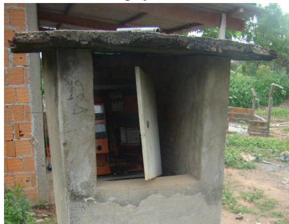
Figura 31. Abrigo e quadro de comando do poço 1
