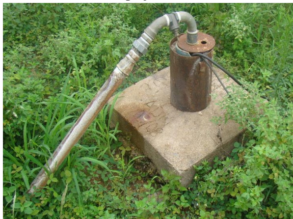
Figura 30. Laje de proteção e cavalete do poço 1
