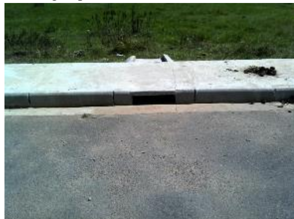
Figura 128. Drenagem de água pluvial
