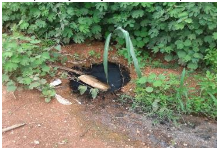
Figura 68. Tubulação de esgoto rompida em frente à estação elevatória
