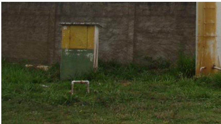
Figura 32. Cavalete e abrigo do quadro de comando do poço
