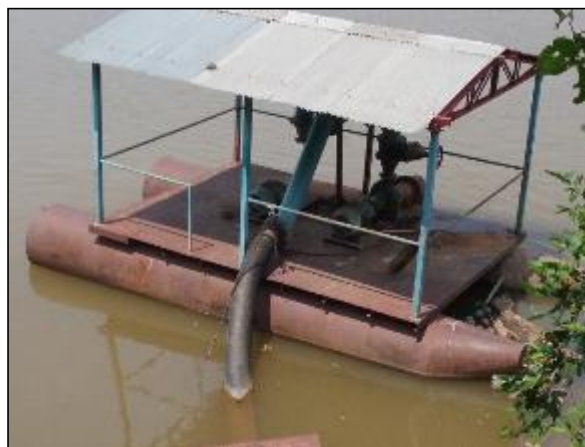
Figura 28. Captação superficial no rio Cuiabá
